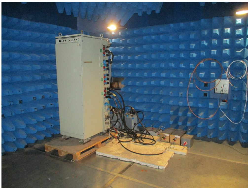
Installation de la baie pour les essais
