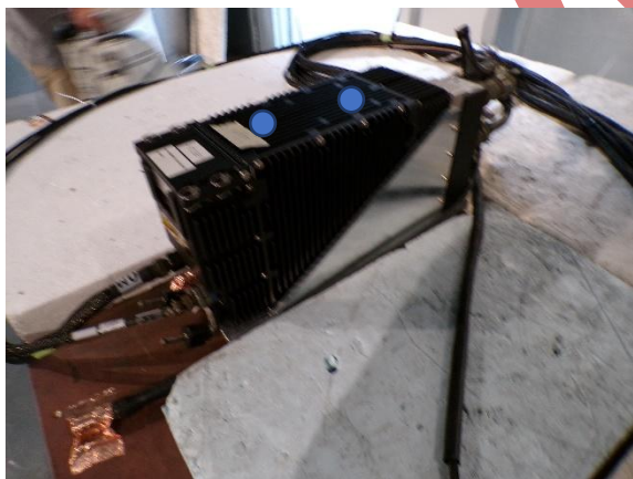
\pm 15\text{kV} sur le dessus ECHEC problème sortie audio
