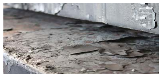
Dépôt de calamine sur une brame à la sortie de coulée continue, formé à 950^\circ\text{C} lors de l'aspersion d'eau.
